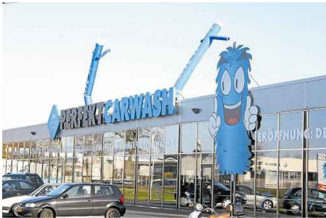
Bei Perfekt Carwash werden fast alle PKW-Typen bis zu einer Höhe von 2,10 Meter gewaschen. Eine moderne biologische Wasseraufbereitung gewährleistet eine 95 prozentige Wiederverwendbarkeit des Waschwassers. Speziell adaptierte Mikroorganismen befreien das Waschwasser von Schadstoffen. Fotos (4): privat
